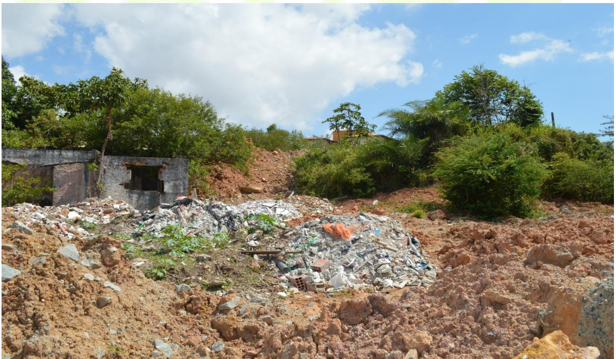
Figura 17 - São Cristóvão - Área da Queiroz Galvão, hoje utilizada para descarte de resíduos da construção civil. 2025.
