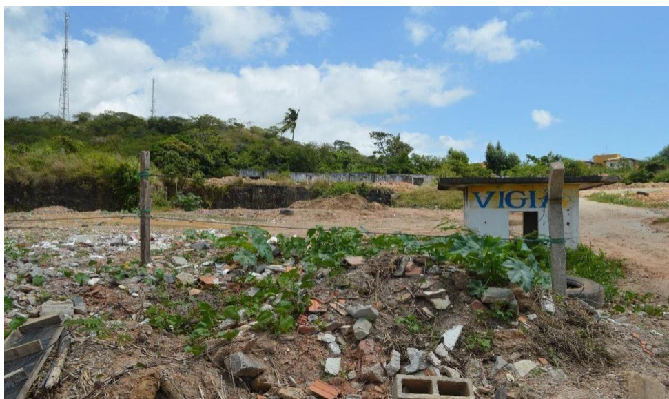
Figura 9. São Cristóvão - Resquícios da antiga guarita da unidade da Queiroz Galvão.
