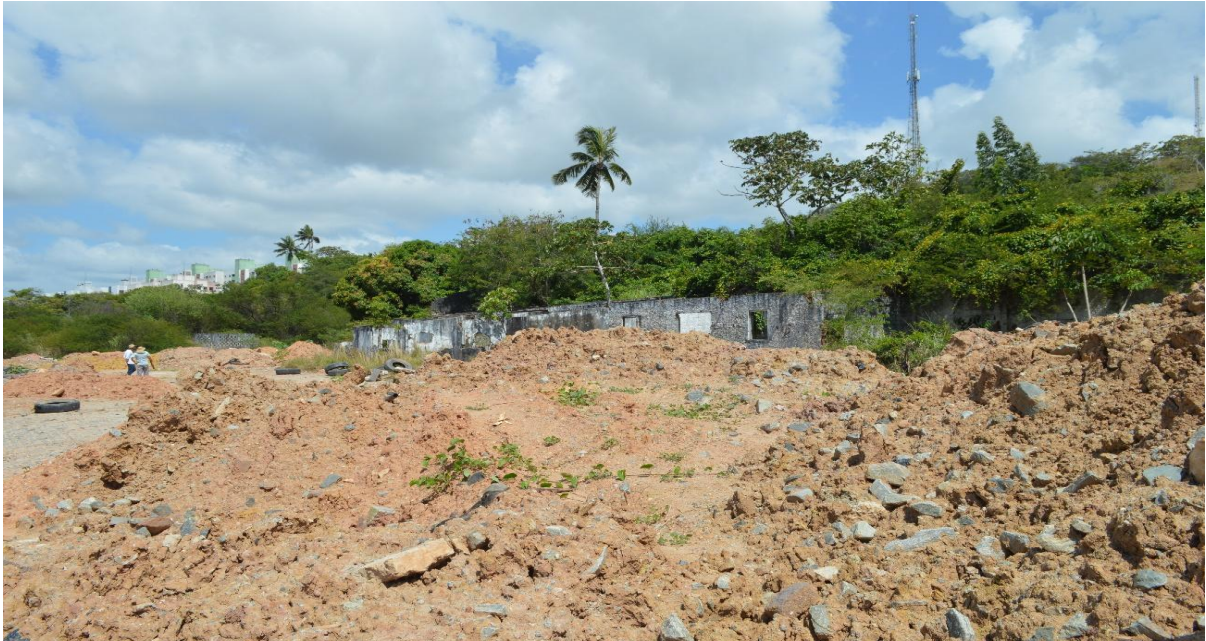
Figura 18 - São Cristóvão - Área da Queiroz Galvão, hoje utilizada para descarte de resíduos da construção civil. 2025.
