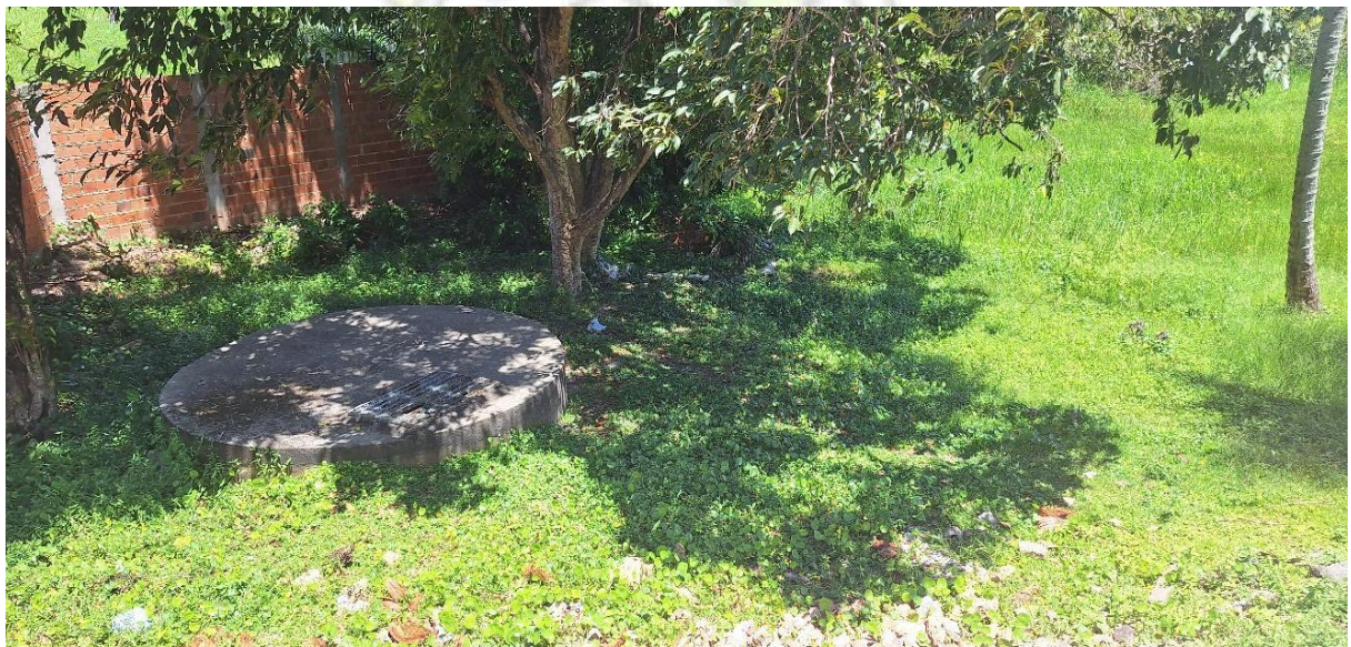
Figura 7 - Aracaju - Cisterna oriunda de captação subterrânea nas imediações do riacho Palame. A água atende a uma loja de material de construção. 2025
