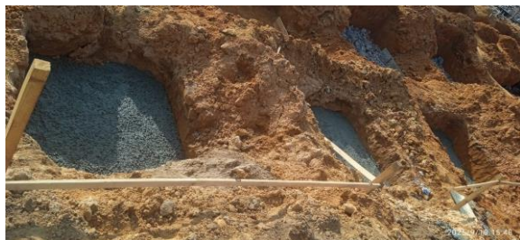
18 de setembro de 2025 - Execução dos lastros das sapatas.
