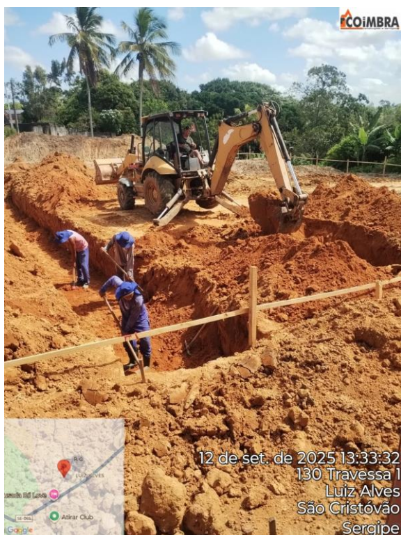
12 de setembro de 2025 - escavações das fundações (sapatas).
