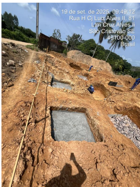
19 de setembro de 2025 - Execução dos lastros das sapatas.
