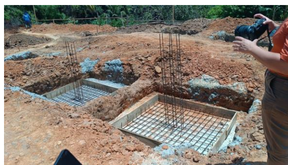
30 de setembro de 2025 - Execução das fôrmas e armaduras das sapatas.
