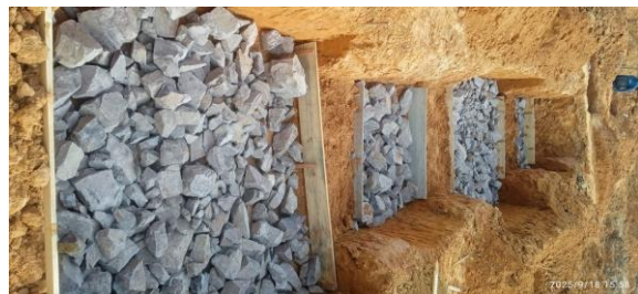
18 de setembro de 2025 - Execução dos lastros das sapatas.
