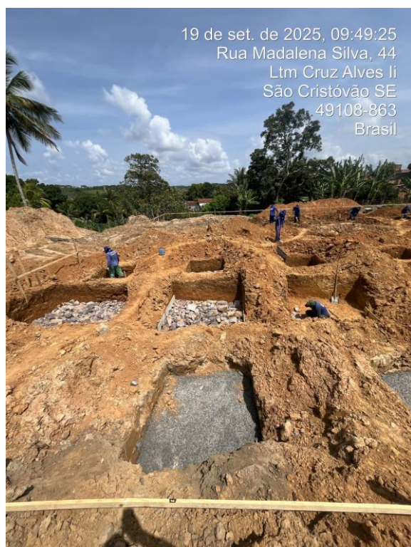
19 de setembro de 2025 - Execução dos lastros das sapatas.
