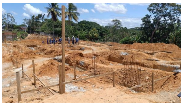
30 de setembro de 2025 - Execução das fôrmas e armaduras das sapatas.
