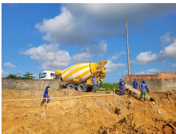
18 de setembro de 2025 – Execução dos lastros das sapatas.
