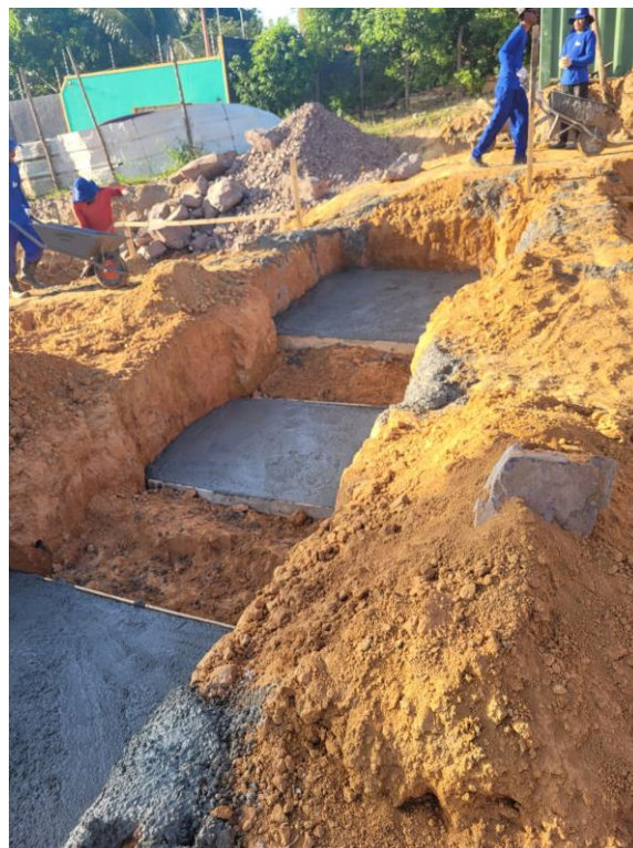
22 de setembro de 2025 - Execução dos lastros das sapatas.
