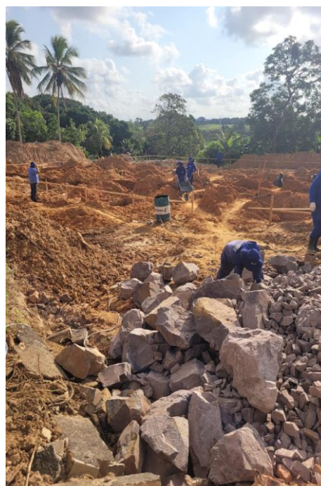
18 de setembro de 2025 – Execução dos lastros das sapatas.
