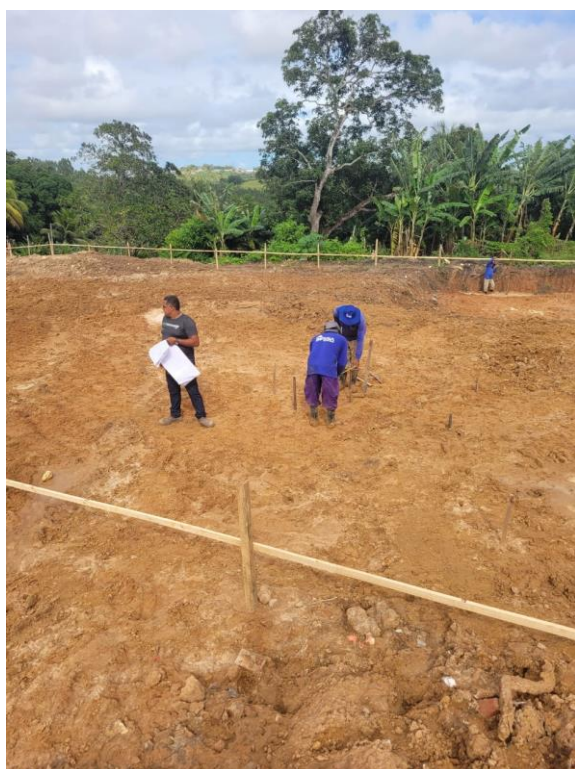
5 de setembro de 2025 - Início das escavações das fundações (sapatas).
