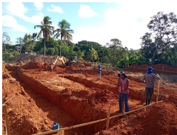
12 de setembro de 2025 - escavações das fundações (sapatas).
