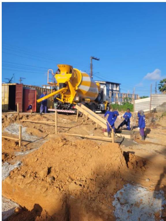
22 de setembro de 2025 - Execução dos lastros das sapatas.
