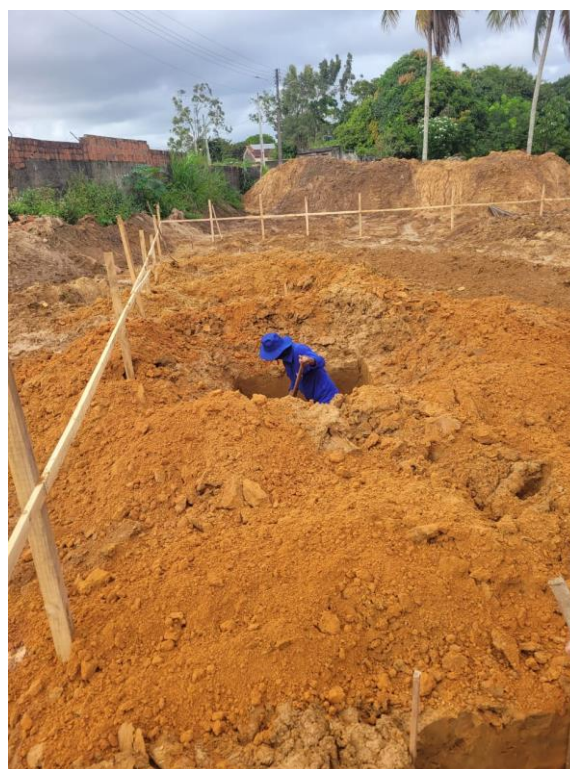
5 de setembro de 2025 - Início das escavações das fundações (sapatas).
