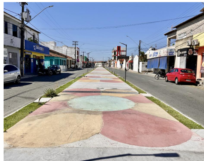
Figura 25 - Cobertura canal da Rua G.
