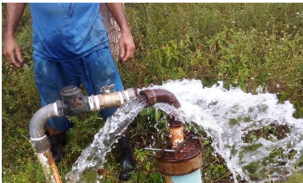
Foto: MEI prestando serviço de bombeiro hidráulico para o SAAE.
