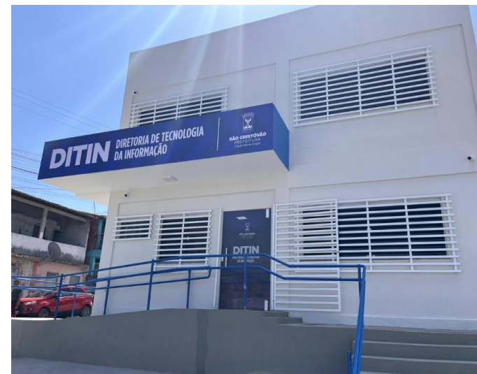
Figura 17 - Construção do Ditin.
