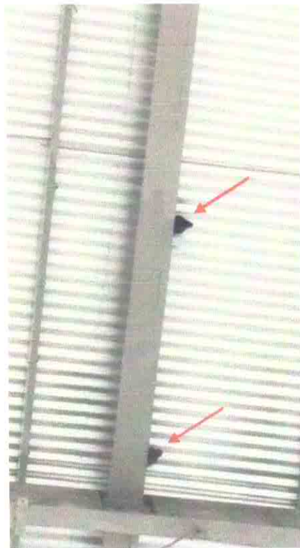
Foto 2 – Imagem aproximada dos pombos na cobertura.
