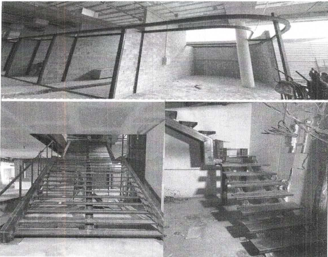
Obra Concluída - Shopping Da Bahia > Estruturas Diversas (Salvador/Ba) - Outubro/2021 - Reforço Estrutural De Laje, Projeto, Fabricação E Montagem De Estruturas Diversas (Marquise De Fachada, Escada Principal, Escada Secundária E Torre Para Elevador De Serviço)
