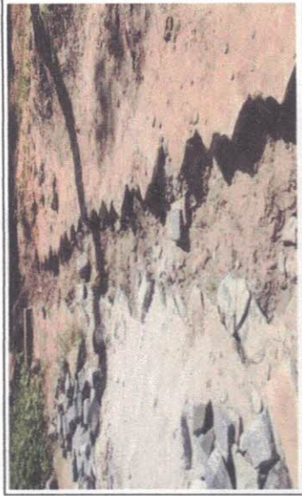
Demolição do Paralelepípedo para retirada de tubulação Deito - Demolição/Excavação/Retirada de tubulação
