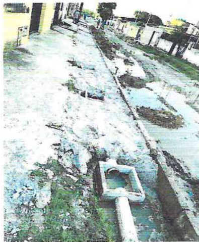
Escavação, Reaterro e instalação de tubulação
