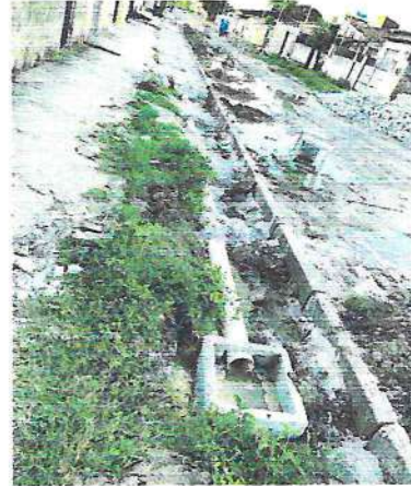
Escavação para instalação da tubulação
