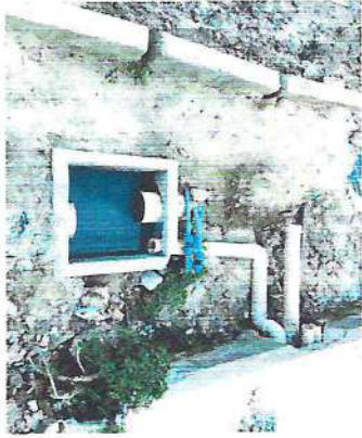
Escavação para instalação da tubulação
